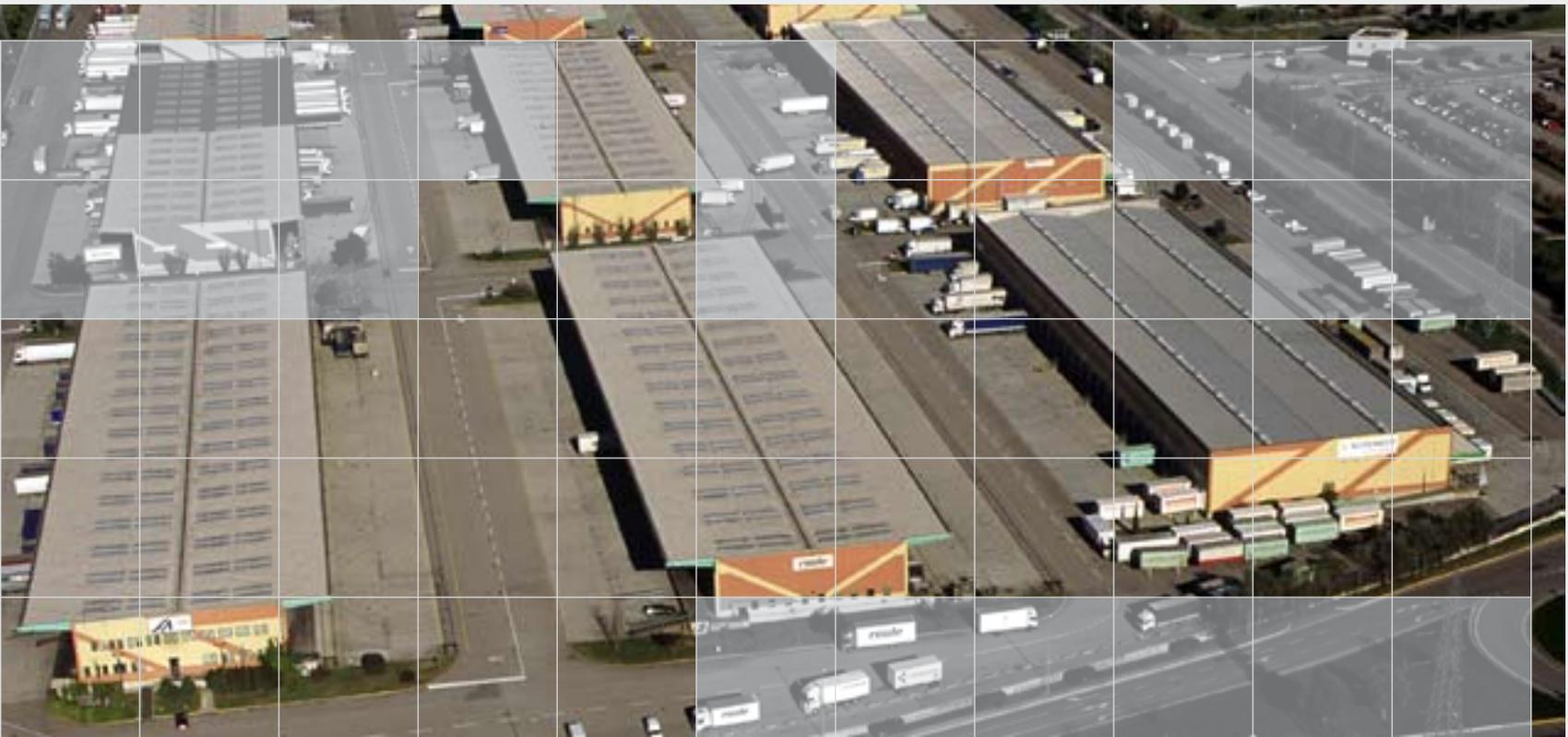
L'edificio è realizzato con materiali di pregio e gradevoli: copertura con travi e pannelli in legno lamellare, rivestimento esterno con murature in c.a. e pannelli coibentati a superficie metallica color grigio alluminio; zona uffici con ampia vetrata continua strutturale per tutta la profondità degli stessi; pensilina sulla zona di accesso agli uffici e muratura in blocchi di calcestruzzo splittati di colori sfumati dal grigio scuro al bianco.
